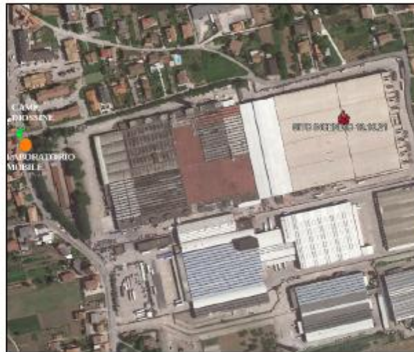
Ubicazione laboratorio mobile e campionatore alto flusso diossine
