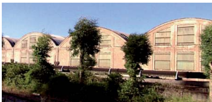
Figura 3.21 - Stabilimento ETERNIT (fonte: Bagnolifutura S.p.A.)
