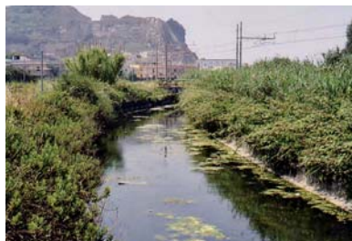
Fig. 6.4 - Piccolo tratto del canale della foce vecchia
