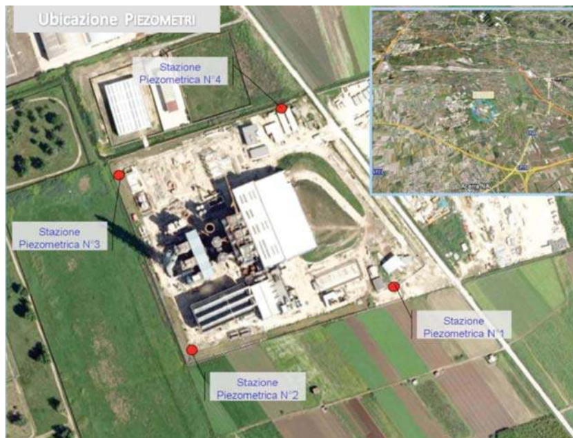
Foto 1 - Ubicazione dei pozzi spia (Fonte Osservatorio Ambientale)
