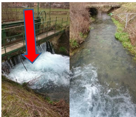
Foto 16-6 e 17-6 Torrente Cavarelli Monte
