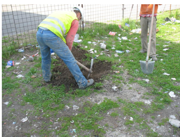
Esecuzione prescavo mediante con attrezzatura manuale
